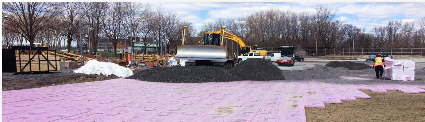
Fondation du terrain sportif — Granulats
