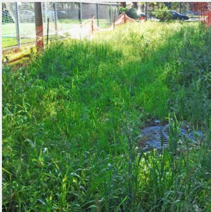
Noue végétalisée avec tranchée drainante Toussaint-Louverture, Montréal
