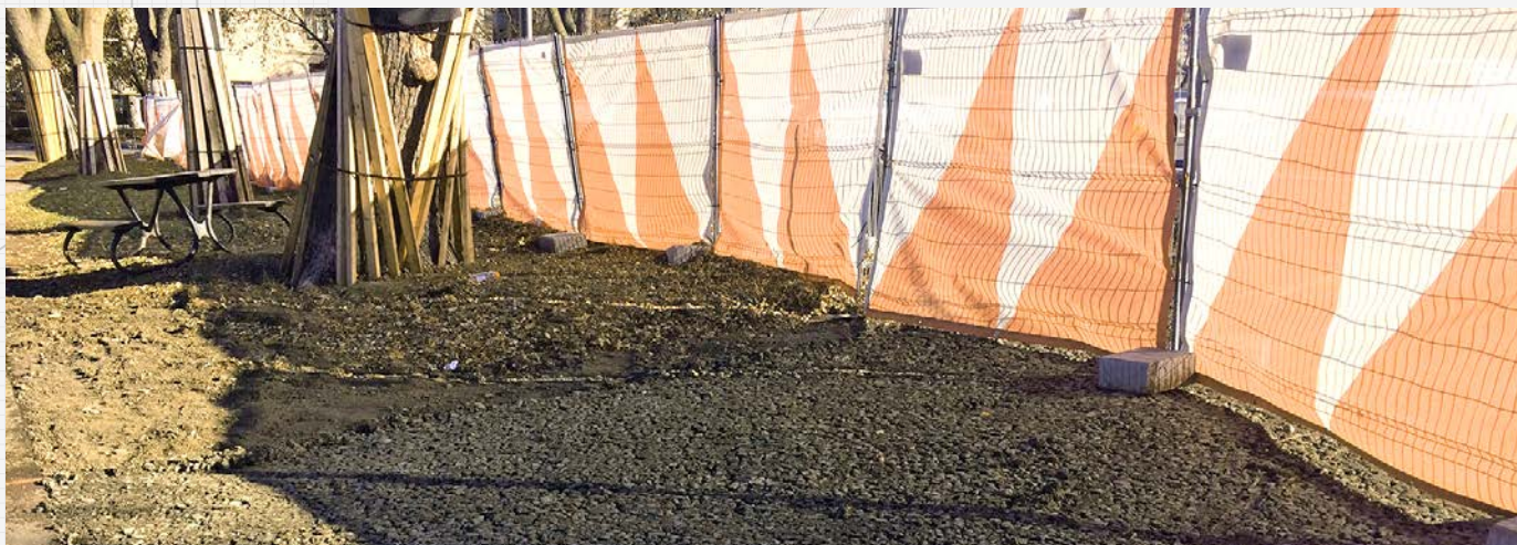
Protection du site
